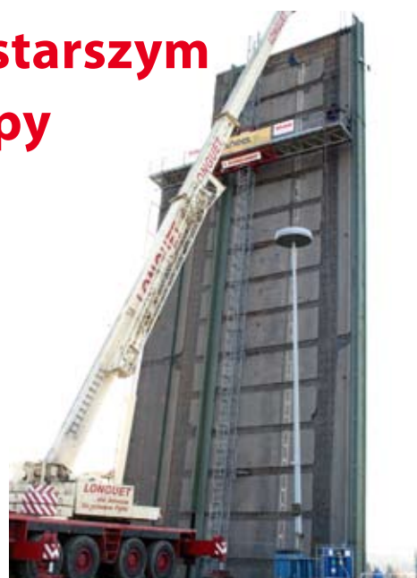
SC4000 na pojedynczym maszcie z pochYLENIEM pod kątem 7°
