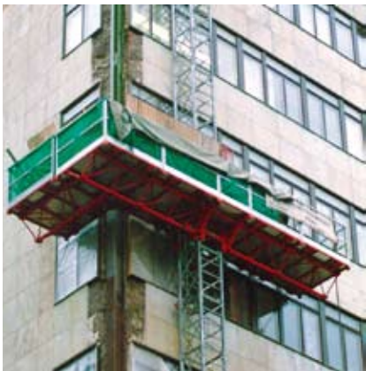
Platformę można obrócić o 90° w stosunku do platformy głównej
